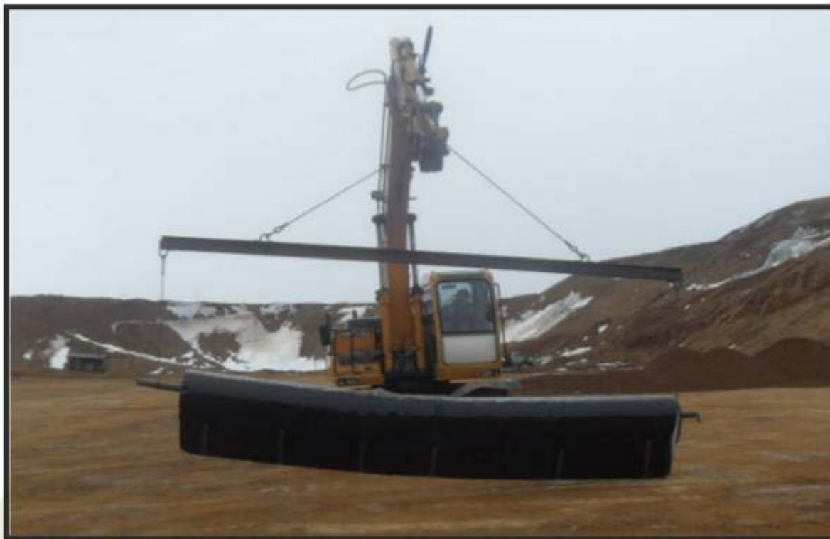
Рисунок 4.14 Траверса для транспортировки и укладки рулонов бентонитового мата
